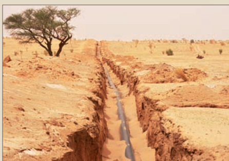
Phase de construction de l'oléoduc qui relie les puits situés dans le Tin Toumma à la raffinerie de Zinder sur 450 km.
